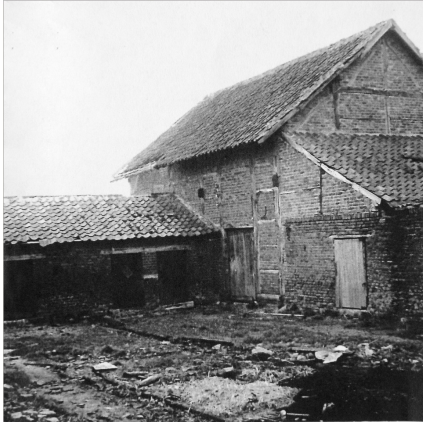
Leprozerie, oorspronkelijk waarschijnlijk 'winning' van het Steen Terlocht
